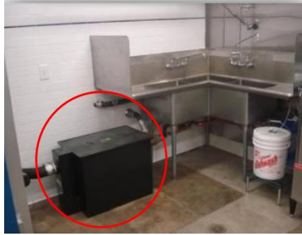
Gambar 2. 9 Contoh Aplikasi Bak Penangkap Minyak dan Lemak yang Menyatu dengan Kitchen Sink
