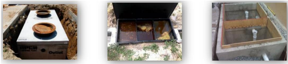
Gambar 2. 10 Contoh Bak Penangkap Minyak dan Lemak untuk Satu Kawasan (Konstruksi di Luar Dapur)
