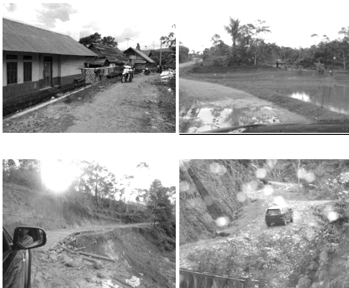
Foto: searah jarum jam, kiri atas: Kondisi jalanan di Desa Citorek yang beraspal namun sudah banyak yang rusak dan berlobang; jembatan kayu sederhana yang dibuat swadaya dari masyarakat; jalanan di dalam desa yang berkontur tanah; jalanan menuju Desa yang rawan longsor apabila terdapat hujan besar; kondisi jalanan yang berbatu menuju Desa
